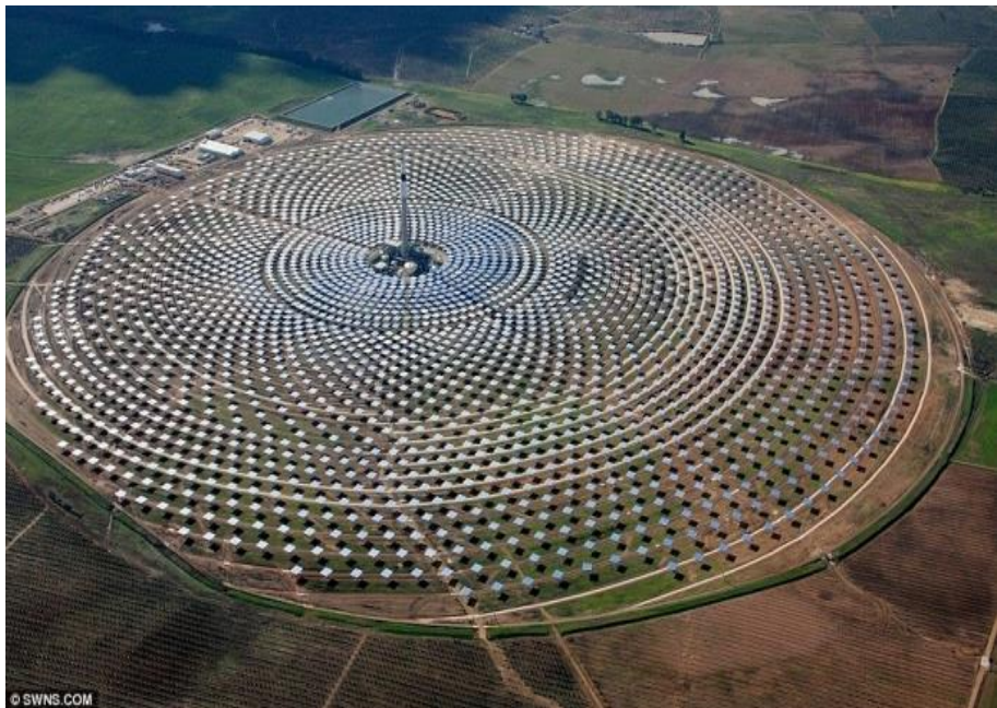
西班牙吉馬太陽能發電廠(日夜發電)
